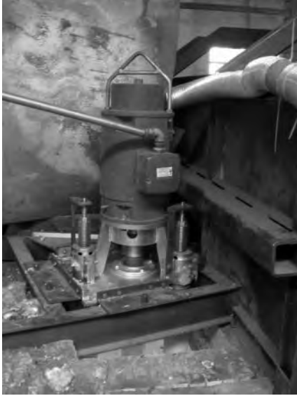
Şekil 13 : Mekanik sirkülasyon pompası
